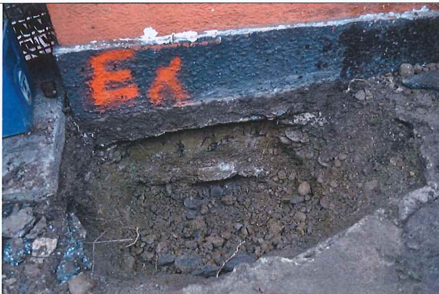
FOTO 1 – Dezvelire fundație S1
